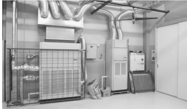
▲2008年10月に設置された3馬力の産業用除湿機（右）。隣は冷風乾燥機として使われている設備用パッケージエアコン
