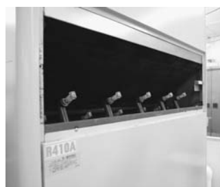
◀冷却フィンにはカチオン電着塗装を採用。目詰まりを防ぐため自動散水装置も組み込まれた
