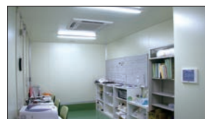
▶製造管理室に設置したAE-200J から、工場内の機器を一括監視・ 操作
