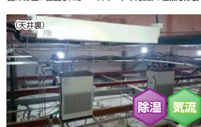
食品工場において重要な“天井裏の結露対策”には、除湿機+エアー搬送ファンを導入して隅々まで除湿
