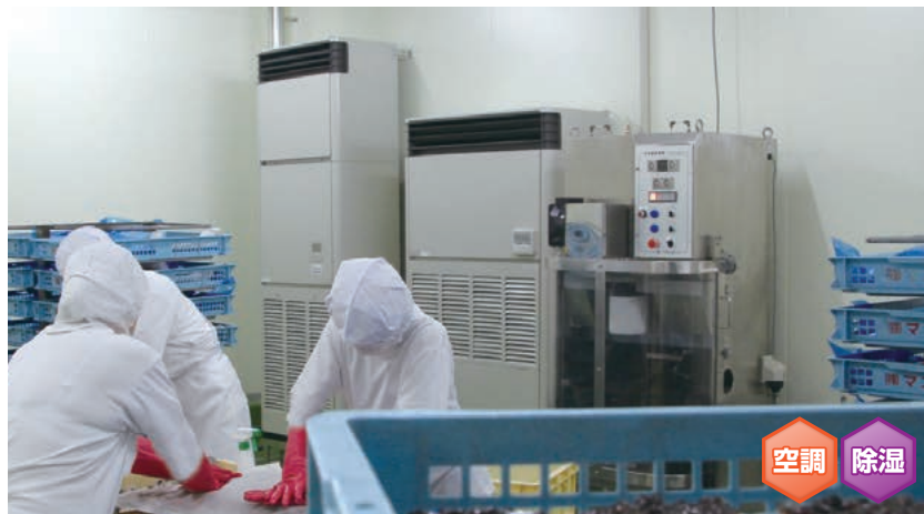
設備用パッケージエアコンと産業用除湿機で、餅製造室の温湿度を一定に管理
