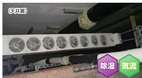
天井裏では壁の隙間を隅々まで除湿するため、エアー搬送ファンの吹き出し方向を工夫して対応
