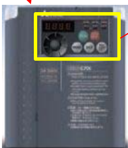
ポンプインバーター 3.7KW仕様
