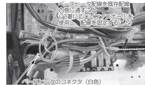
以上のようにベースヒータの据付および電気配線の接続が確実に行われていることを必ず確認してください。
