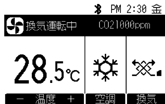
メイン画面(空調換気)
