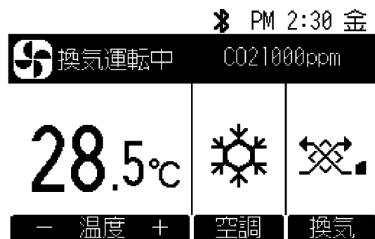
メイン画面(空調換気)
