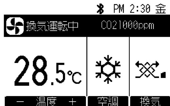
メイン画面(空調換気)
