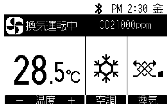
メイン画面(空調換気)
