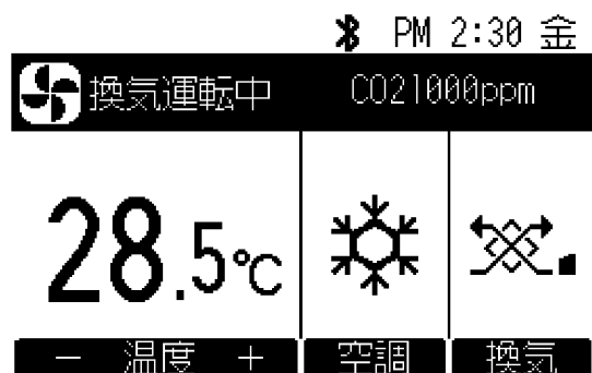
メイン画面(空調換気)
