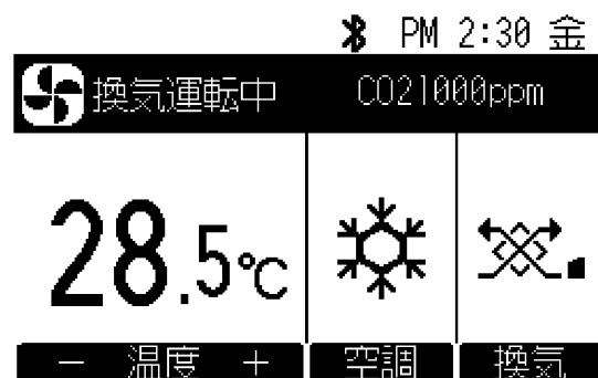
メイン画面(空調換気)
