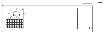
◎システム立ち上げ通信完了にて、グループ別設定/モニタ画面となります。
