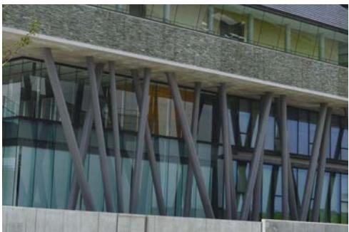
▲開放的な内部空間と効果的な免震性能を実現するために、「竹林トラス」と呼ばれている二重の梁を1階から3階の外周に使用しています。
