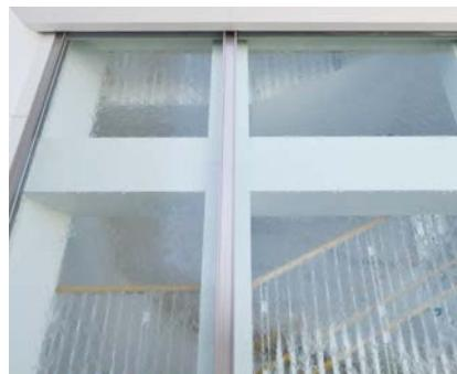
▲さらに定期的に窓ガラスに水を流し、室内温度の上昇を抑制します。
