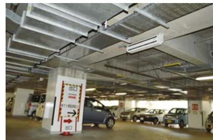
▲地下駐車場の温度上昇や排気ガス対策をエアーアー搬送ファンで解消します。
