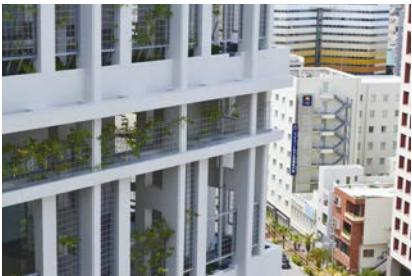
▲外壁ルーバーの採用により沖縄の強烈な日射の遮蔽と適度な通風を確保しています。
