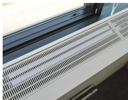
▲グリーンポイドで熱せられた空気の浮力を利用して、冷涼で新鮮な外気を取り込み、冷房エネルギーを削減します。
