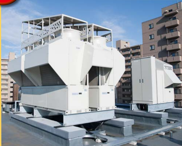
▲基礎は既設チラーのものを流用。DT-Rは筐体がコンパクトなため、既設チラー1台分のスペースで2台設置することができた
