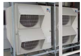
▲食堂内に「ぐるスマ」を導入。 ▲室外ユニットには室外カバー、防 ムラなしモードでムラなく快適な環境を 雪フード、架台を設置し、積雪対策 実現。も万全。
