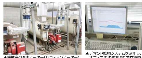
▲機械室の温水ヒーター(バコティンヒーター)。3台のうち右の1台は取替用
