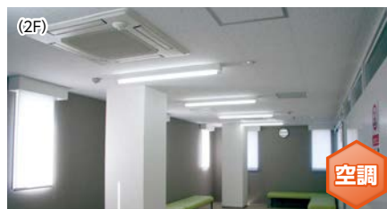
休憩室や更衣室には、ムーブアイ付のビル用マルチエアコンを採用。温度ムラを解消して省エネ性・快適性を向上 (写真は女子更衣室)
