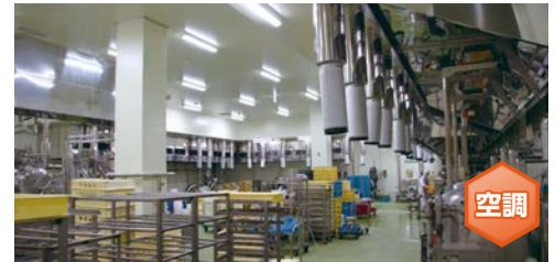
面積の広い製造ラインの空調には、必要な箇所にのみ吹出しダクトを配置
