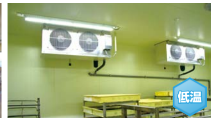
館冷却室に設置されたユニットクーラで、製品の粗熱を除去
