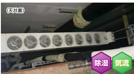
天井裏では壁の隙間を隅々まで除湿するため、エア－搬送ファンの吹き出し方向を工夫して対応
