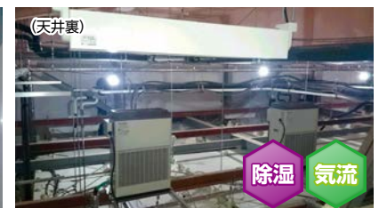
食品工場において重要な“天井裏の結露対策”には、除湿機+エア－搬送ファンを導入して隅々まで除湿
