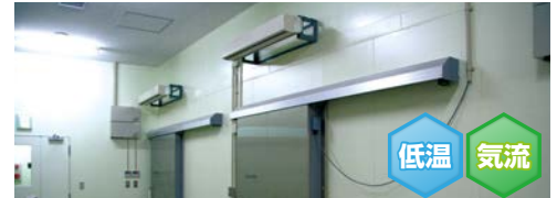
原料冷凍庫の扉上部に設置されたエア－搬送ファンで庫内の冷気を保護
