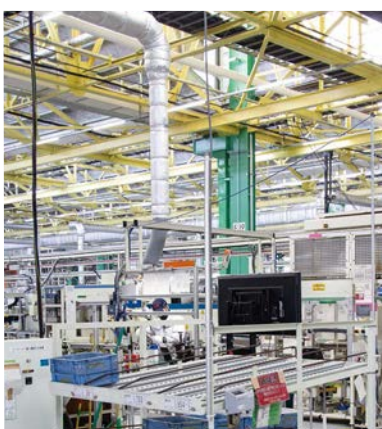
▲最新設備への更新で、より働きやすい環境をライン作業者に提供
