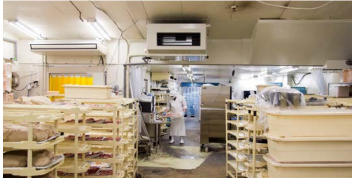
▲チェーン各店舗用の精肉パックを製造している精肉センター。その中央部に設置された「ハイブリッド式産業用除湿機」
