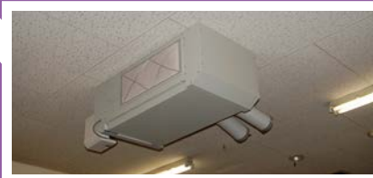
▲粉末による目詰まりを防ぐため、吸込み口にフィルタを装着。清掃と定期交換で機器をメンテナンスしている。
