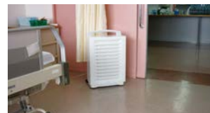
第8病棟 設置状況
