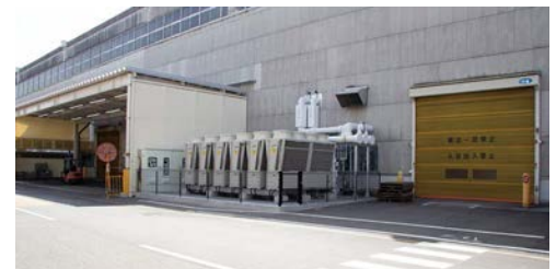
▲安全確保の観点から、両端のユニットにはフィン保護網を装着
