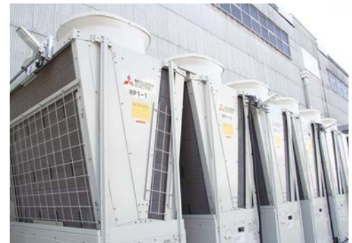
▲安全確保の観点から、両端のユニットにはフィン保護網を装着
