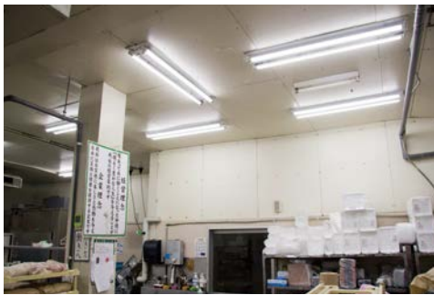
▲天井や壁の結露は改善された
