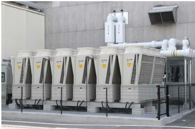
▲第4鋳造工場内の作業員に対する温熱環境改善として採用した空冷式ヒートポンプチラー「DT-RIII」
