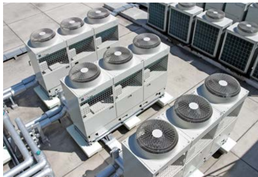
▲一定速のブラインクーラ(BAL-P750D×3台)は、醗酵室を38℃に保つため、エアハンドリングユニットの冷却に使用。加温が必要な場合は蒸気で行う
