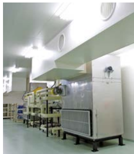
▲一定速のブラインクーラ(BAL-P750D×3台)は、醗酵室を38℃に保つため、エアハンドリングユニットの冷却に使用。加温が必要な場合は蒸気で行う
