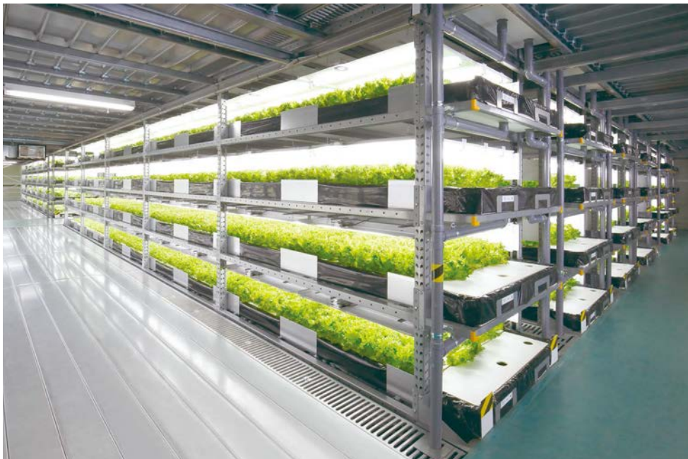
▲ほぼ無菌状態に近い室内で水耕(養液)栽培されるレタス。施設照明には、三菱電機のFHF 32W蛍光灯器具トラフ形5,504台を採用。育苗棚用のみLEDにすることで初期コストを抑制した
