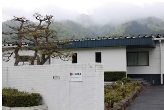
▲安芸太田工場では海苔原料を保管し、焼海苔、味付海苔、佃煮などに加工。衛生管理されたクリーンルームで製造、原料の品質保持の為に大形冷凍庫を完備。
