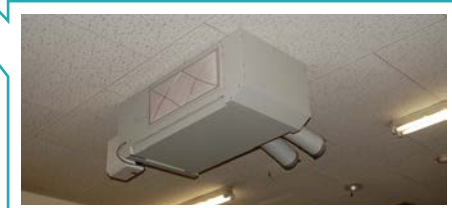
▲粉末による目詰まりを防ぐため、吸込み口にフィルタを装着。清掃と定期交換で機器をメンテナンスしている。
