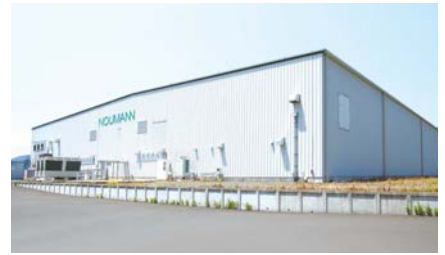
▲工場の延床面積は3,700㎡。美浜町の企業誘致助成金の適用を受け、操業停止中の野菜工場を改修
