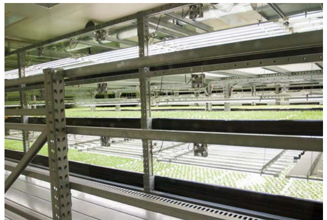
▲見学通路からみる育苗棚。上から下へ吹く空調気流を誘引ファンで棚の間に引き込む。天井の太いパイプは二酸化炭素供給用
