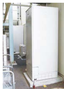
エコキュート設置写真
