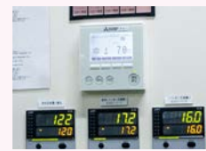
▲チラーのリモコンは機械室の制御盤に設置された
