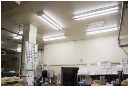
▲天井や壁の結露は改善された
