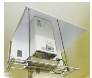
熱湯供給器 ※検査の為、エコキュートの湯を再沸騰させる装置です。
