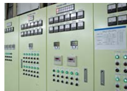
▲機械室にあるブラインクーラの制御盤
