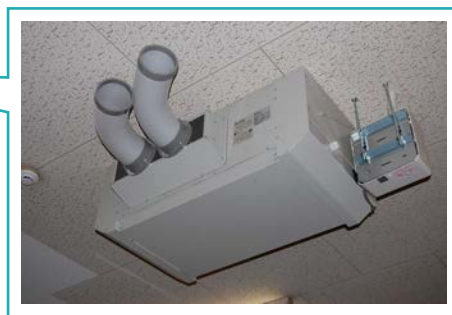
▲オプションパネル仕様で天井面ピッタリ設置。またプレナム+フレキシブルダクトで風向調整し効果的に除湿。
