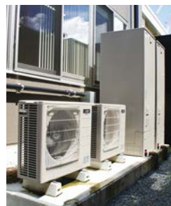
エコキュート設置写真(2台) [ベーカリー・寿司・惣菜作業室]
