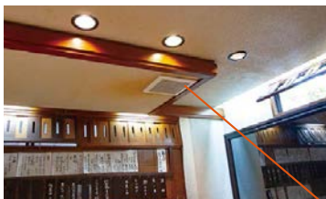
カウンター席のダクト用換気扇。更新後の機種はDCブラシレスモーターを搭載、省エネルギーに優れ、配管圧損に左右されず安定した換気風量を確保できる
