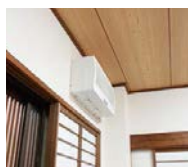
カウンター席のダクト用換気扇。更新後の機種はDCブラシレスモーターを搭載、省エネルギーに優れ、配管圧損に左右されず安定した換気風量を確保できる
