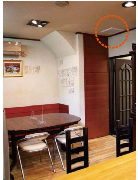
CO 2 センサー搭載換気扇はメインルームのテーブル席の近くに設置。室内は約5坪あり、カウンターと併せて15名まで着席可能
