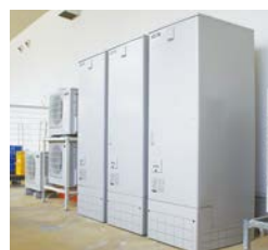
エコキュート設置写真(3台) [青果・鮮魚・精肉作業室]
