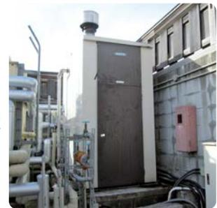
▶10年使用の既存ボイラー。デマンド制御でホットウォーターヒートポンプが停止した場合や、厳寒期に温水温度が50℃以下になった場合、サーモ自動運転によりバックアップ
