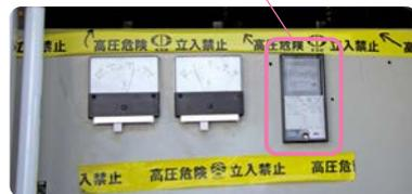
▲既存キュービクルの高圧回路側にバルブ交換器を設置。リアルタイムでバルブ信号を出力
