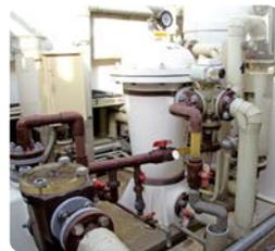
◀露天風呂で冷めた湯はろ過器を通過した後、熱交換器(既存)でホットウォーターヒートポンプからの高温水と熱交換され露天風呂へと循環
