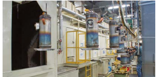
▲塗装前の湯洗工程(温水利用側)
