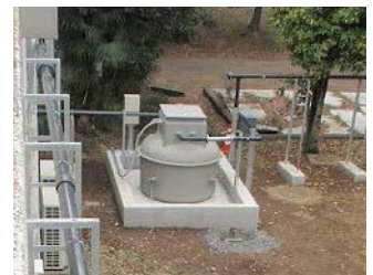
中継タンク(水中ポンプ内装)
