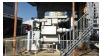
▲今回の空調設備更新に伴って撤去された、既設のガス吸収冷温水機と冷却塔
