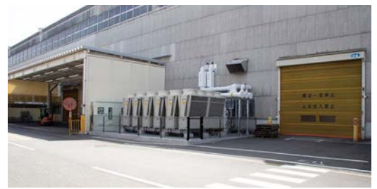
▲安全確保の観点から、両端のユニットにはフィン保護網を装着
