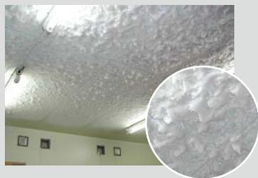
霜取時に天井面付近温度上昇による露垂れ
