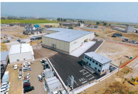
▲旧施設より200メートル南に移転。写真は本社事務棟(右下)、低温倉庫(中央)、常温倉庫(左)
