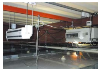
▲産業用除湿機とエア搬送ファンの組合せによる、天井裏の結露対策を実施
