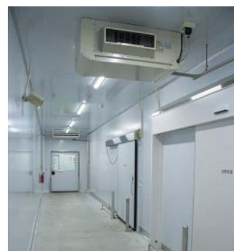
▲冷蔵庫や冷凍庫に接する通路には産業用除湿機を設置し、ドアの開閉時の冷気流入による結露発生を防止
