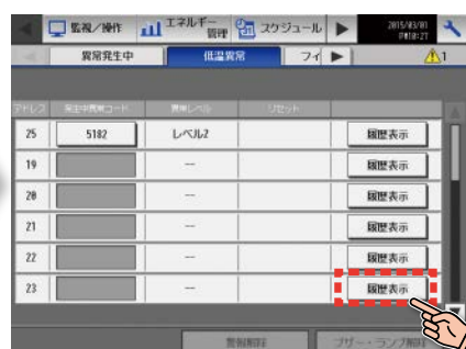
異常発生中一覧
