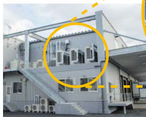
▲1階屋根上に集中設置されたR410Aインバータ二段スクロールリングユニット(AFSV)
