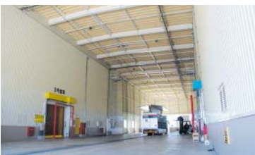
▲今回新たに設けられた全天候型の作業場
