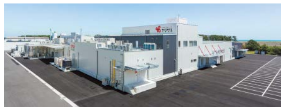
▲建築面積10,925㎡、延床面積12,868㎡、地上2階建の吉田住吉工場
