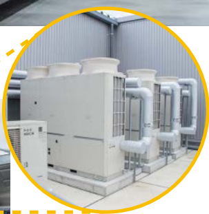
▲1階屋根上に集中設置されたR410Aインバータ二段スクロールリングユニット(AFSV)
