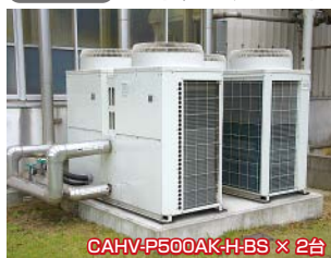
▲工場横に連続設置されたホットウォーターヒートポンプ
