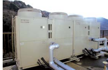
▲ 熱損失の多い男女露天風呂の保温に必要なエネルギーを4台のホットウォーターヒートポンプで負担
