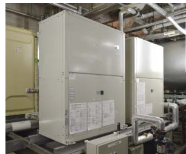
▲今回ご採用いただいた2台の水熱源ヒートポンプ(浴室給湯用)。温泉施設の排熱を有効活用し、ランニングコストを大幅削減。
