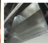
▲吹出しカバーを設けることでショートサイクルを防止。冷風は室内温度上昇を抑えるために活用。
