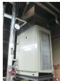
▲吹出しカバーを設けることでショートサイクルを防止。冷風は室内温度上昇を抑えるために活用。
