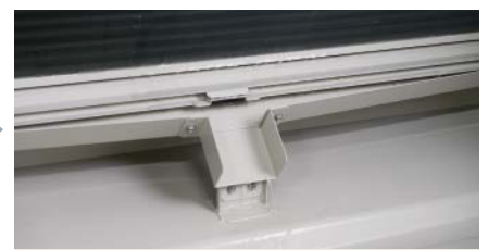
熱交換器清掃カバーを開けます。
