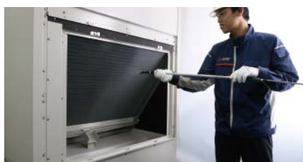
熱交換器を水で洗浄します。
