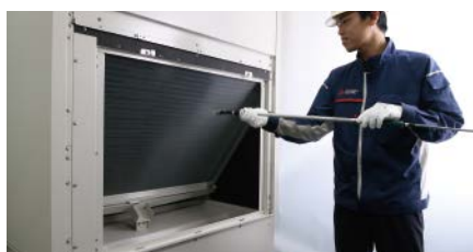
熱交換器を水で洗浄します。
