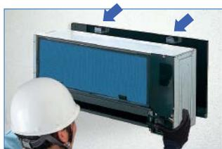
据付枠上部の金具(スライドレール)を手前に引き出す。その後、本体を金具に引っかける。
