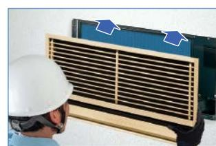
本体を壁(据付枠)の中に押し込み、前面グリルを取り付ける。
