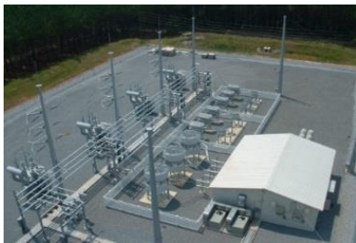
静止型他励式無効電力補償装置(SVC*)
