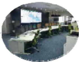
監視制御システム
