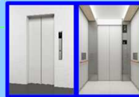
エレベーター
