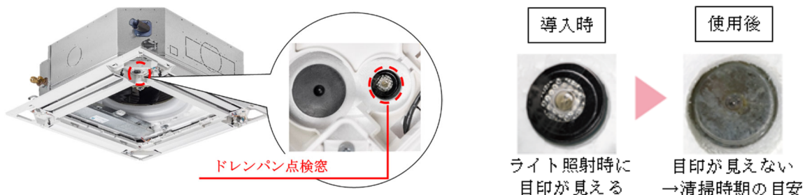
図7 ドレンパン点検窓と汚れ具合の確認イメージ
